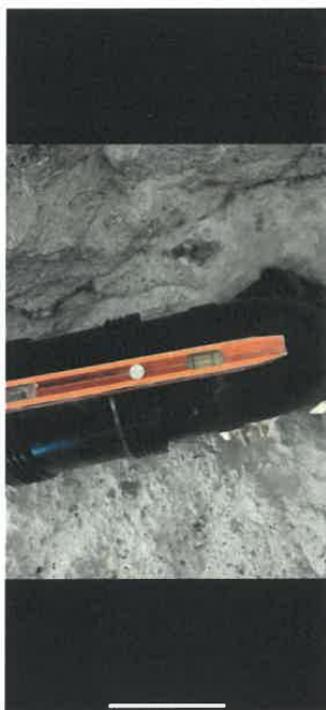
Skjema: "Småjobber: Røropplegg bad" Spørsmål: Sjekklister småjobber Beskrivelse: Fall, Filnavn: 421BA4A4-F611-477E-85E7-CE59677CEF8E.png
