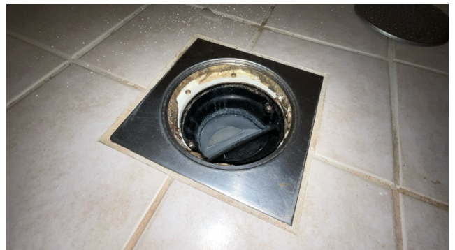
Kontroll av sluk.
