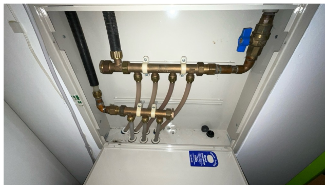
Besiktigelse av røropplegg.
