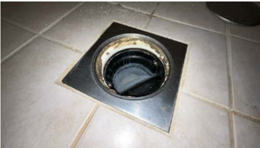
Kontroll av sluk.
