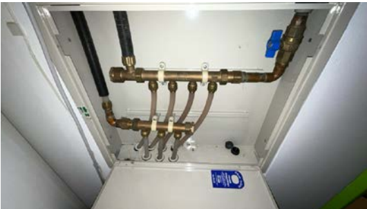
Besiktigelse av røropplegg.
