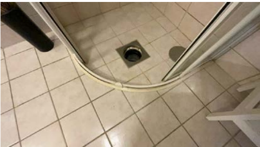
Tilrenning til sluk gjennom dusjrammen bør opparbeides.
