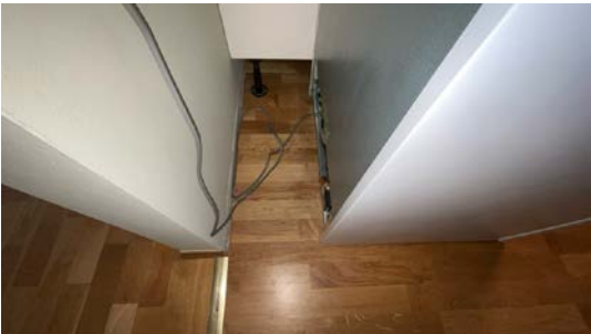
Kontroll bak kjøleskap. Ingen tegn til fuktskader på befaringsdagen.
