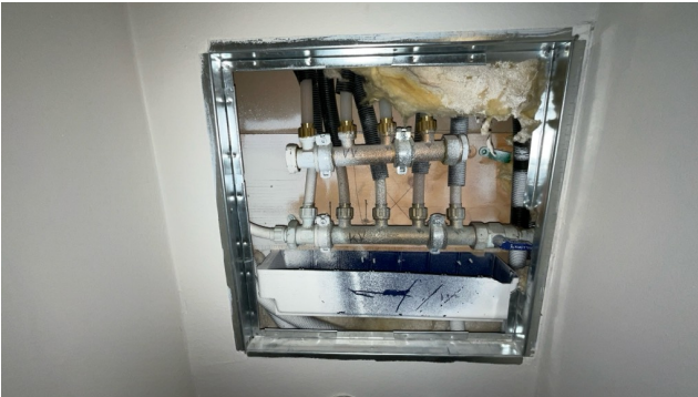
Besiktigelse av røropplegg. Kurser er merket på fordelerstokk, men bør merkes med lapper.
