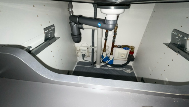
Besiktigelse av røropplegg.
