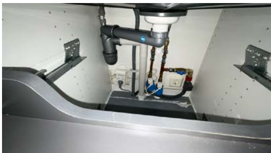
Besiktigelse av røropplegg.
