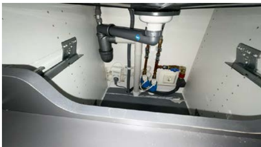
Besiktigelse av røropplegg.
