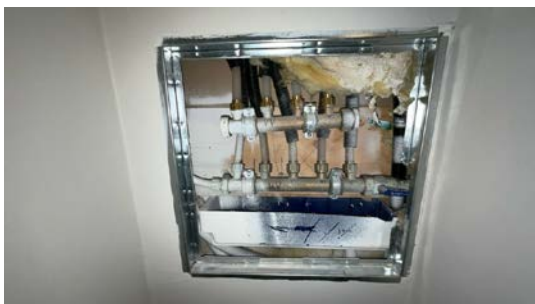
Besiktigelse av røropplegg. Kurser er merket på fordelerstokk, men bør merkes med lapper.
