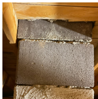
Gjenstående del av elementpipe ført gjennom tak. Utvendig pipe er fullbeslått
