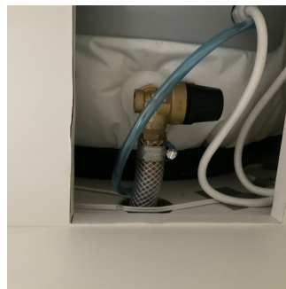
Bereder i kjøkkenbenk, avløp fra sikkerhetsventil og fast EL-tilkopling
