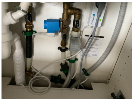
Røropplegg i kjøkkenbenk med installert WaterGuard _ Montert og testet 15.12.2023
