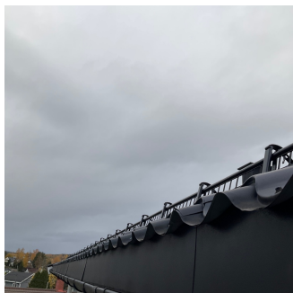
Montert snøfangere på takflaten over inngangsparti
