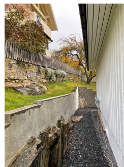
Område med skrått terreng mot nabo
