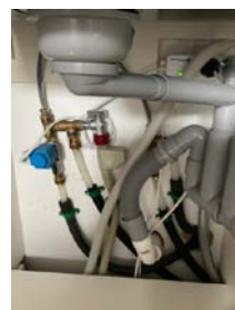
Røropplegg i kjøkkenbenk med WaterGuard
