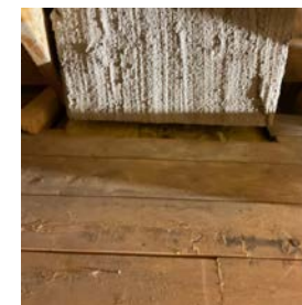
Gjenstående del av pipe over bjelkelag på kaldt loft
