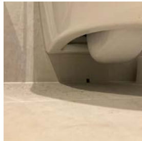
Spalte for lekkasjevarsler nederst ved innkasset systerne
