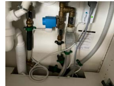
Røropplegg i kjøkkenbenk med installert WaterGuard _ Montert og testet 15.12.2023
