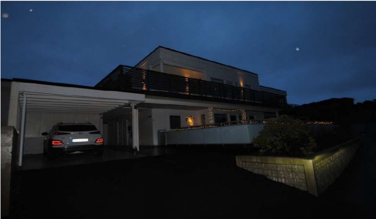
Bilde 5: Boligen sett fra nedsiden
