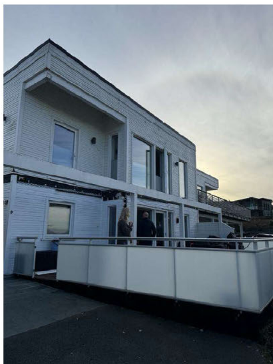
Terrasse for 331 er demontert med kun bærekonstruksjon gjenstående. Hele terrassen for 329 fremstår tilgjengelig.
