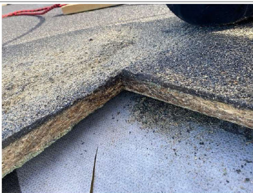
Kontroll av tak.
