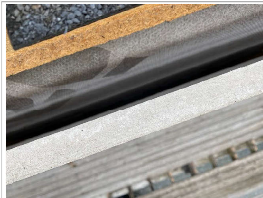
Kontroll av tak/ vegg.
