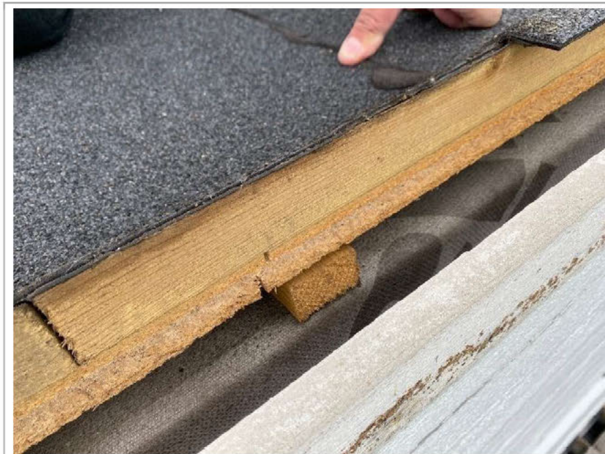
Kontroll av tak/ vegg.
