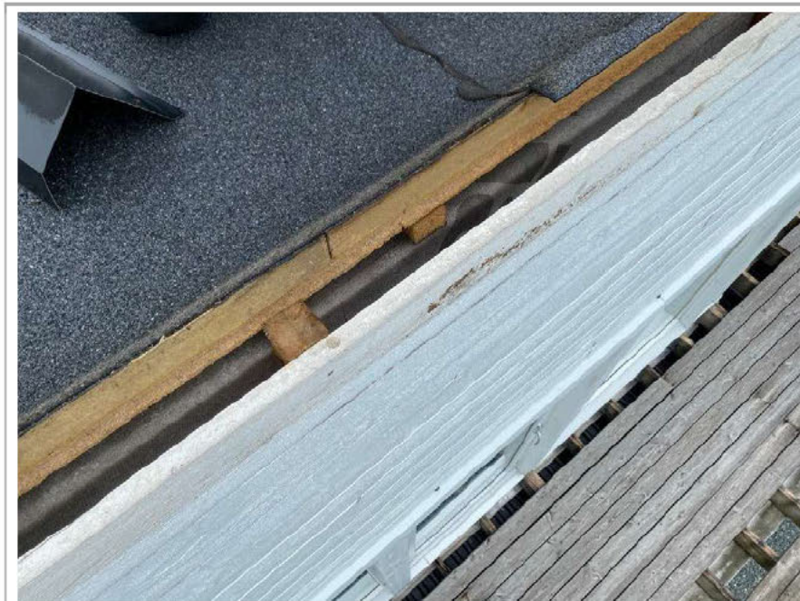
Kontroll av tak/ vegg.
