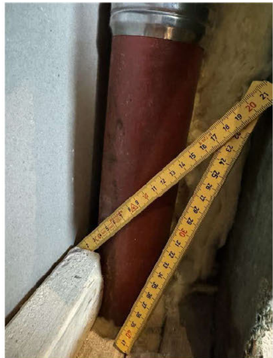
Det er muggsopper og klare spor fra tidligere lekkasje bak gipsvegg.
