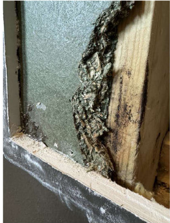
Det er muggsopper og klare spor fra tidligere lekkasje bak gipsvegg.
