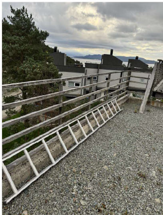
Rekkverk og trapp fra 329 A til 329 B.
