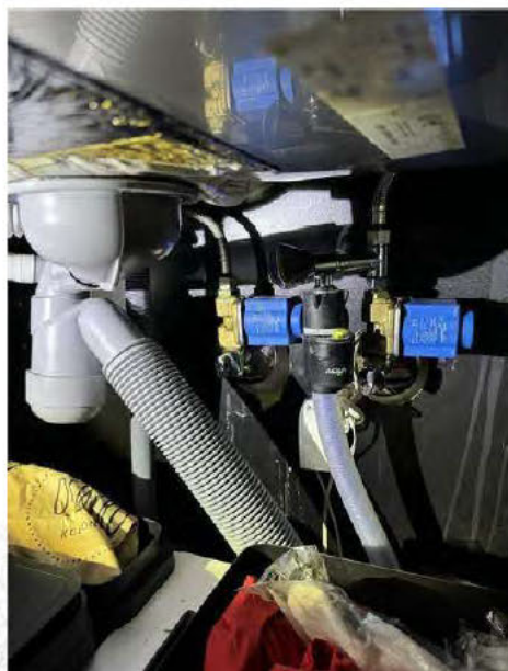
Kjøkken B: Rør opplegg er oppført ut fra brannvegg.
