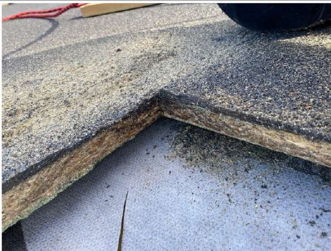
Kontroll av tak.
