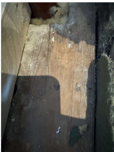
Åpning til ve. på bilde er arealet som tidligere har vært reparert etter vannlekkasje.
