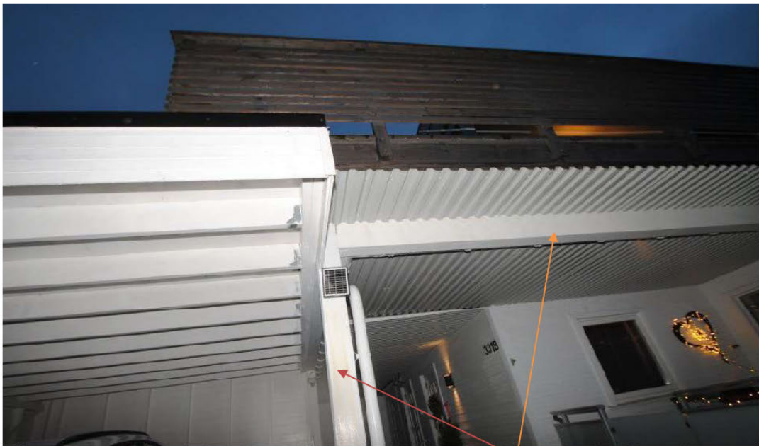
Bilde 6: Samme sted- nedenfra. Vi kunne ikke se skader i bærende konstruksjoner, der vi kontrollerte
