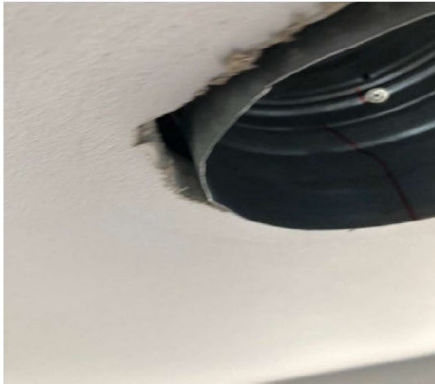
Gjennomføringer ventilasjon
