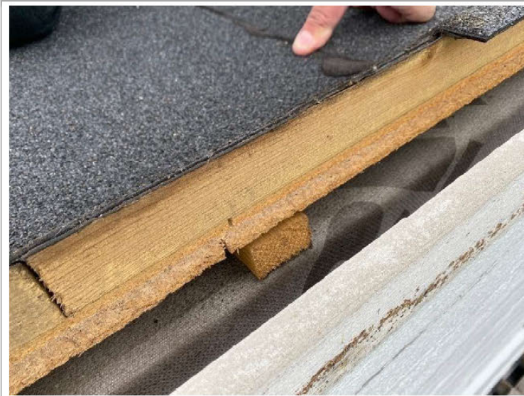
Kontroll av tak/ vegg.
