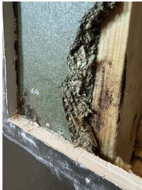
Det er muggsopper og klare spor fra tidligere lekkasje bak gipsvegg.
