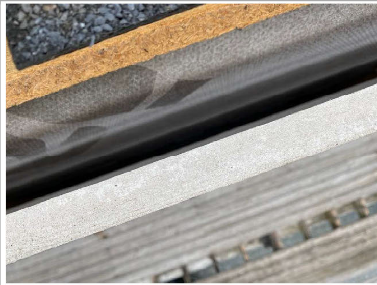
Kontroll av tak/ vegg.
