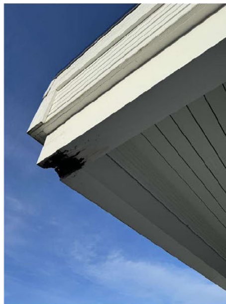
Bilde fra befaring 04.04.2025:
