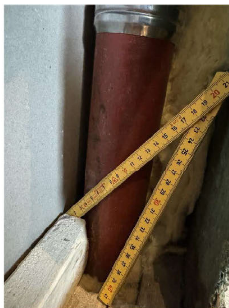
Det er muggsopper og klare spor fra tidligere lekkasje bak gipsvegg.
