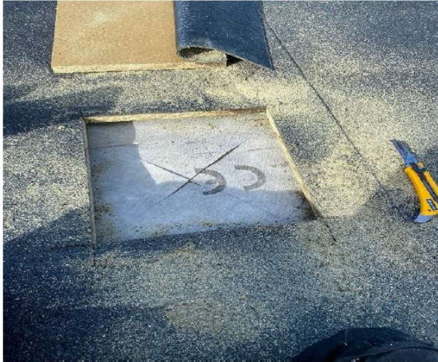
Kontroll av tak.
