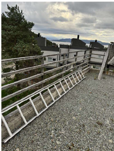
Rekkverk og trapp fra 329 A til 329 B.
