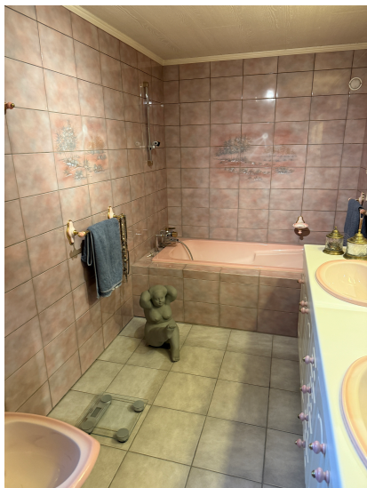
Sluk på bad i kj.etasje
