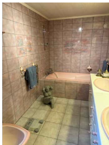
Sluk på bad i kj.etasje
