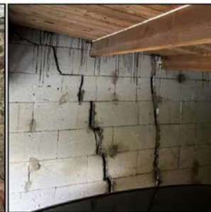
Bilde 3: Sprekk i ringmur har forplantet seg opp i bærende vegg av porebetongblokker.
