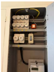
Skrusikringer med skap i felles trappegang.
