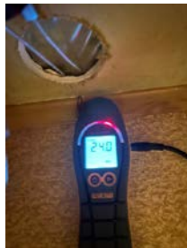
Fuktsøk i vegger i rom underterreng
