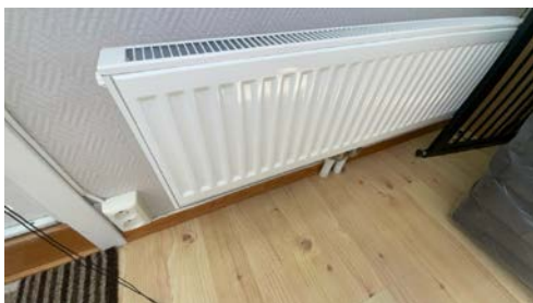
vannbårent varmeanlegg
