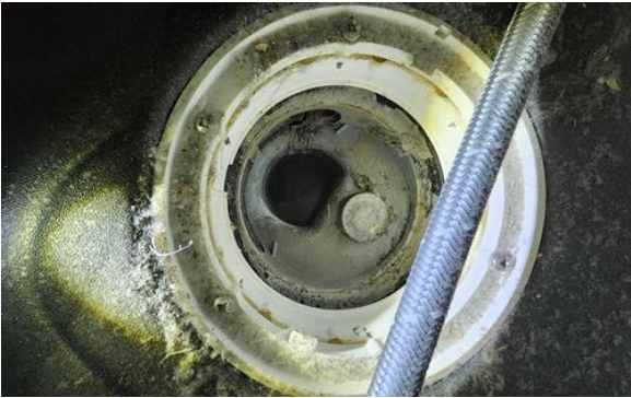
Avløpsrør (ink. sluk) - [Sluk på vaskerom ]
