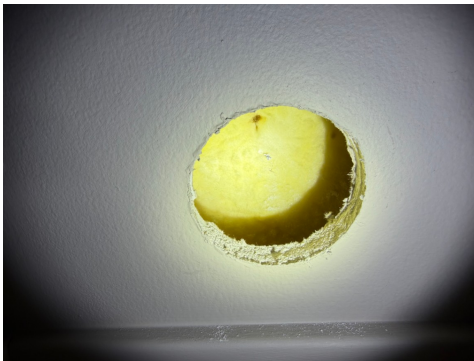
Synlig del av veggkonstruksjon etter hulltaking.
