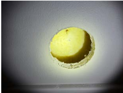
Synlig del av veggkonstruksjon etter hulltaking.
