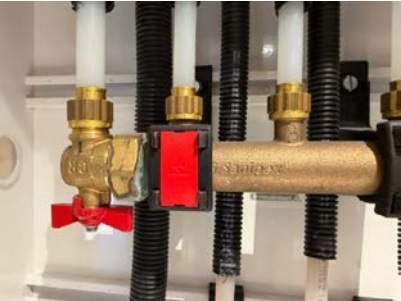
Noe irr på ende av samlestokk i rør i rør skap. Ingen tegn til lekkasje eller fukt.
