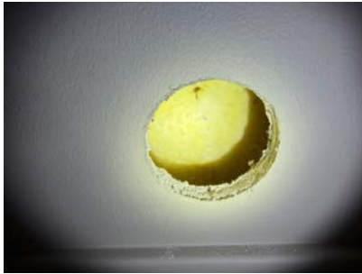
Synlig del av veggkonstruksjon etter hulltaking.
