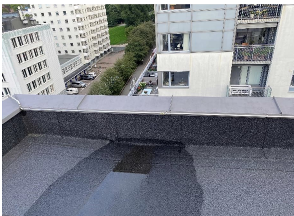
Gassrørledning langs parapet
