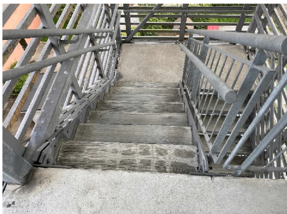
Betong i inntrinn
