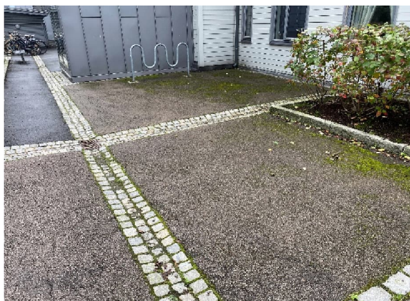
Sørg for åpne overvannsrenner
