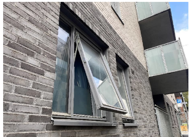
Vinduer med toppsvingmekanisme
