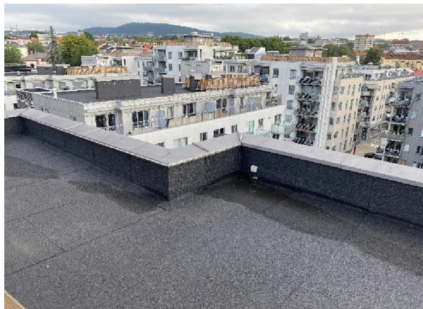
Defekt varmekabel vil føre til skader
