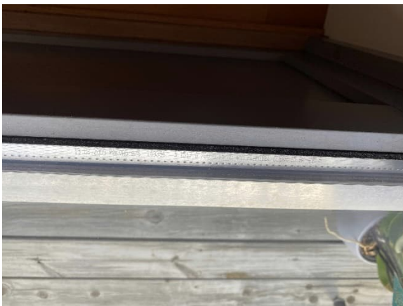
Vindu i befart leilighet er datert 2009
