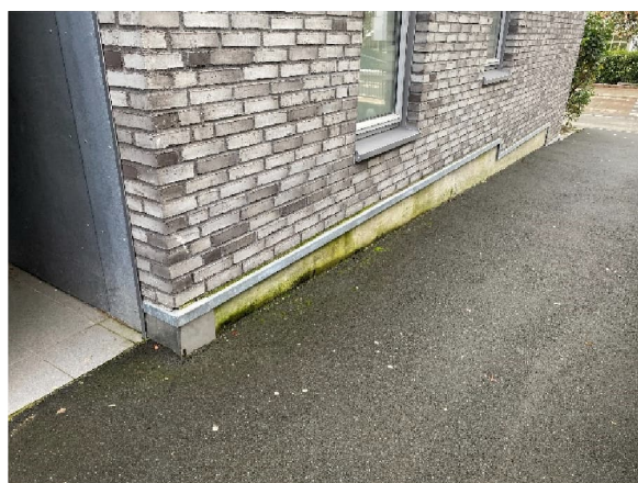
Vann mot grunnmur fører til vekst av grønnalger
