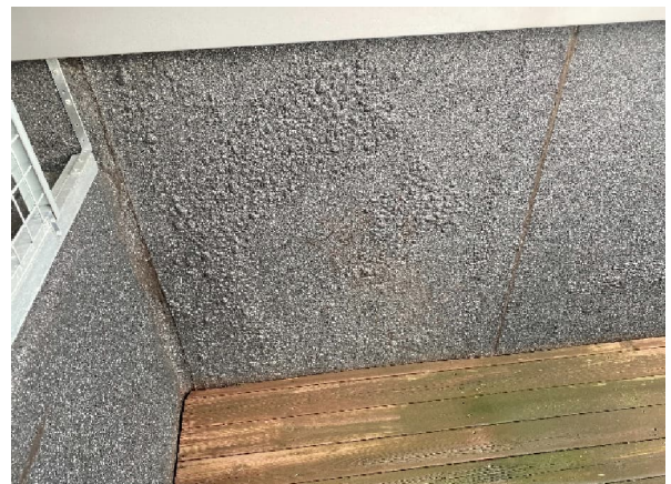
Noe varmebobling i papp
