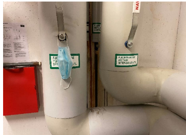
Stengeventiler for fjernvarme
