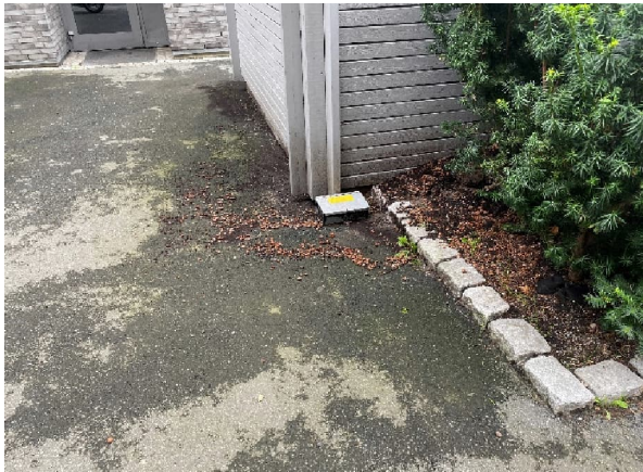
Flere åtestasjoner settes ut ved behov
