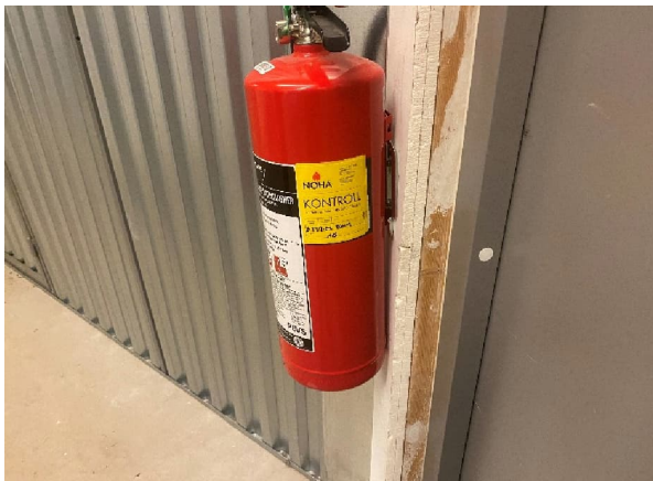
Pulverapparat med avtale om periodisk kontroll
