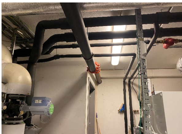
Rørføringer ligger åpent i kjeller
