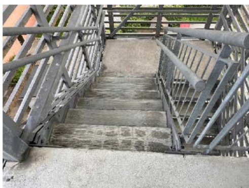
Betong i inntrinn
