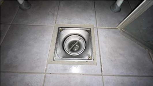
Kontroll av sluk.
