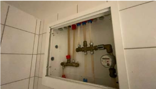
Besiktigelse av røropplegg.
