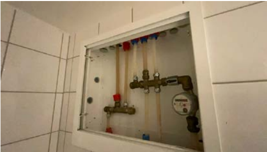
Besiktigelse av røropplegg.
