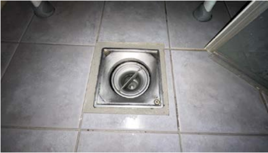
Kontroll av sluk.
