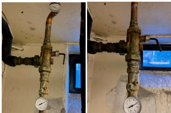
Punkt 4 blokk 9 og 11
