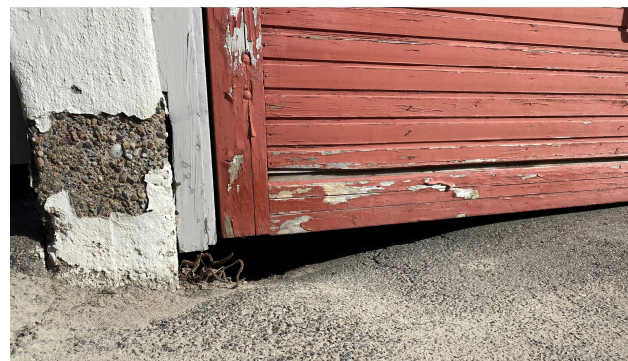
Bilde 3: Sprekk i ringmur har forplantet seg opp i bærende vegg av porebetongblokker.
