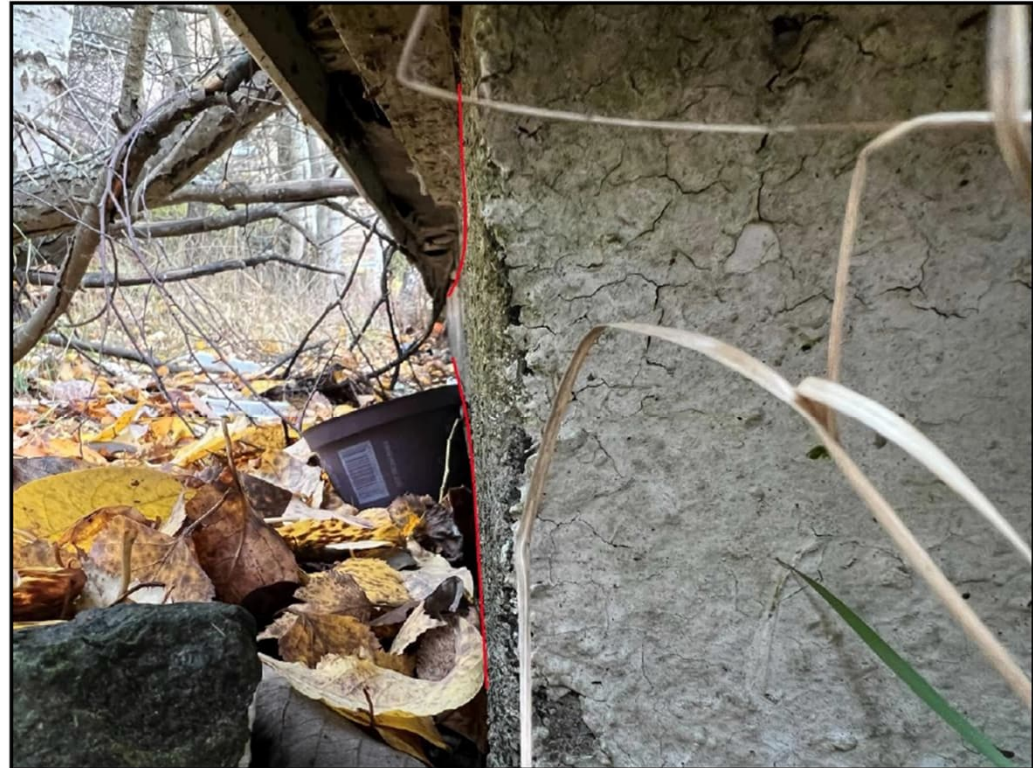
Bilde 7: Tydelig svikt i bakre betongvegg. Veggens overkant og underkant mot massene markert i rødt viser innsving. Garasjerekke felt B
