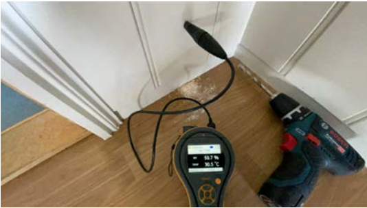
Bilde viser måling av luftfuktighet (RF)
