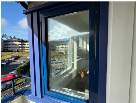
Vinduer med utvendige metallbeslag
