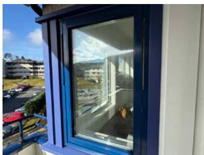
Vinduer med utvendige metallbeslag
