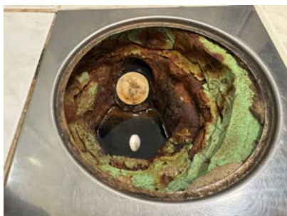
Sluk med synlig membran, men uten klemring
