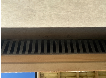
Lufting best musebånd i bakkant av kledning
