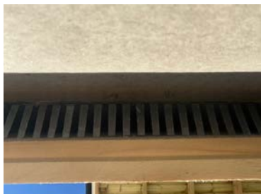
Lufting best musebånd i bakkant av kledning
