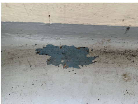
Noe malingsflass i ytre del av altangulv.
