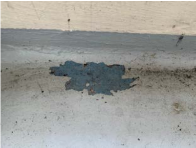
Noe malingsflass i ytre del av altangulv.
