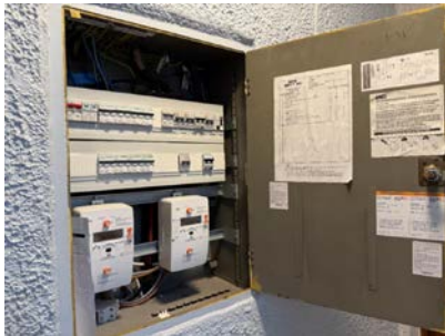
Sikringsskap i fellesarealer. Sikringer som tilhører leiligheten, er på venstre del i skapet.
