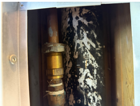
Rørkobling bak inspeksjonsluke i entre/gang/kjøkken.
