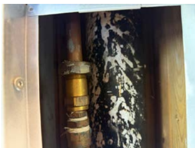
Rørkobling bak inspeksjonsluke i entre/gang/kjøkken.
