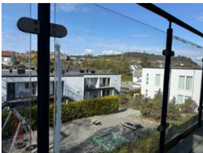
Fargeforskjell/hvit sky på kant av glass på rekkverk.
