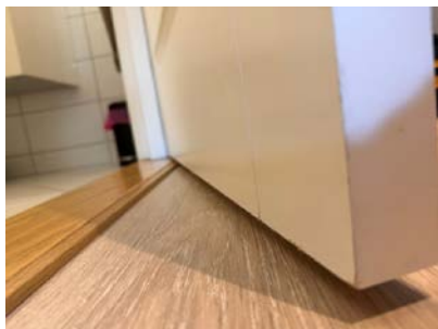
Noe svelling i nedre del av badedør. Må anses å være normal slitasje.
