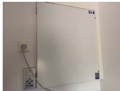
Luftbehandlingsaggregat på vaskerom.
