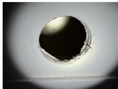
Synlig del av veggkonstruksjon etter hulltaking. Det er montert hvit blindlokk etter hulltaking.
